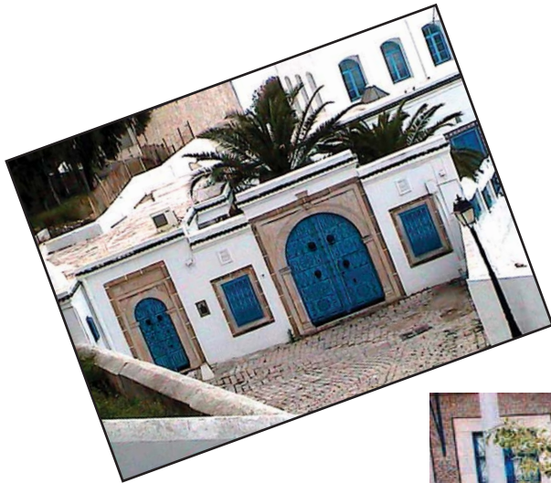
واجهة منزل تقليديّ (سيدي بوسعيد)
